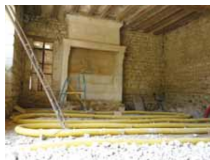
3/ Mise en place d'un drain en serpentin tous les 80 cm au cœur du hérisson.
