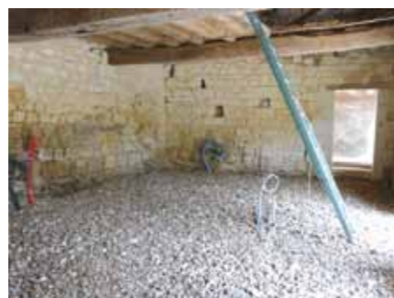
2/ Pose d'une nappe de cailloux de roches dures sur le sol naturel.
